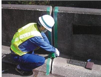
養生テープにてシール塗布部の際を養生する。 (写真では研磨ブラシで塗布面の下地調整も行った)
