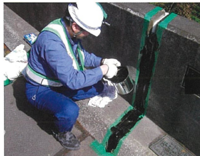
混合攪拌したスカイシール F-2 をゴムベラにて目地に充填。ベラにて平滑に仕上げる。
