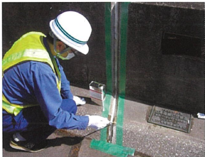
コンクリート面等付着面にプライマー-Uを原液にて塗布する。(塗布量 0.1~0.2kg/m 2 目安)
