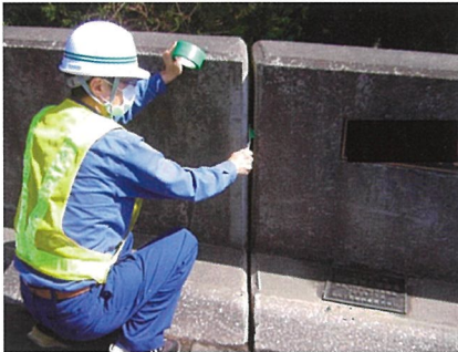
既存目地材を撤去し、ワイヤブラシ等でゴミ・埃を除去清掃を行う。
