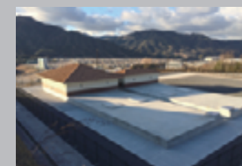
■石内北調整池
