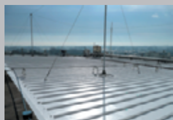
■MR工法施工例
