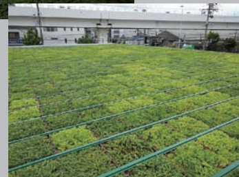
■金属屋根施工例
