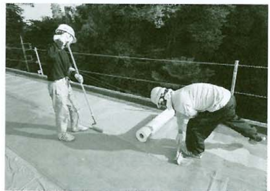
写真-3 防水材料塗布(補強布の積層)
