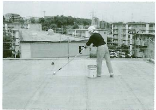
写真-2 プライマー塗布
