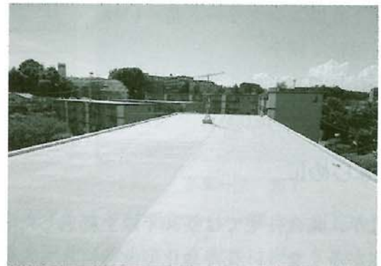
写真-4 施工完了
