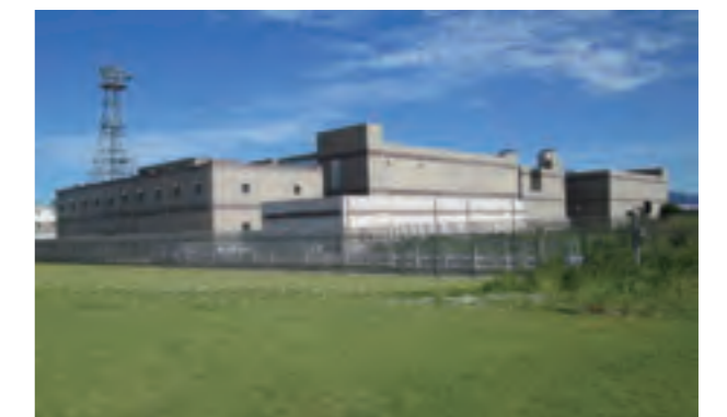
大阪府庭窪浄水場
