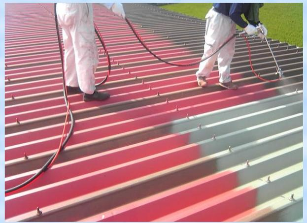
ビッグサンMR工法は、アクリル系樹脂を主成分とした高柔軟性のポリマーセメント系塗膜防水材と太陽熱高反射塗料による金属屋根専用工法です。
