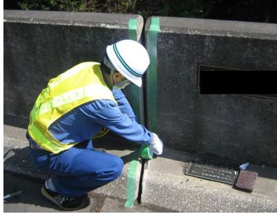
養生テープにてシール塗布部の際を養生する。 （写真では研磨ブラシで塗布面の下地調整も行つた）
