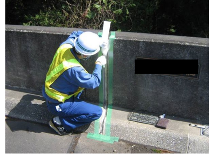
軟質ウレタン材等を遊間部に挿入。シール深さが一定になるように位置を決定し固定する。
