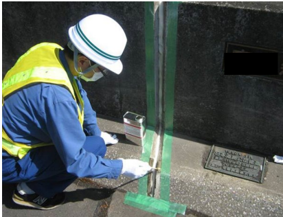
コンクリート面等付着面にプライマーUを原液にて塗布する。（塗布量 0.1～0.2kg/m 2 目安）
