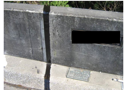
スカイシール F-2 充填施工完了。
