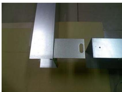
見切り材を固定した固定板に載せる
