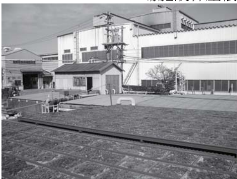
工場施設棟屋根
