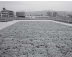
福祉施設屋上 (VUS500)
