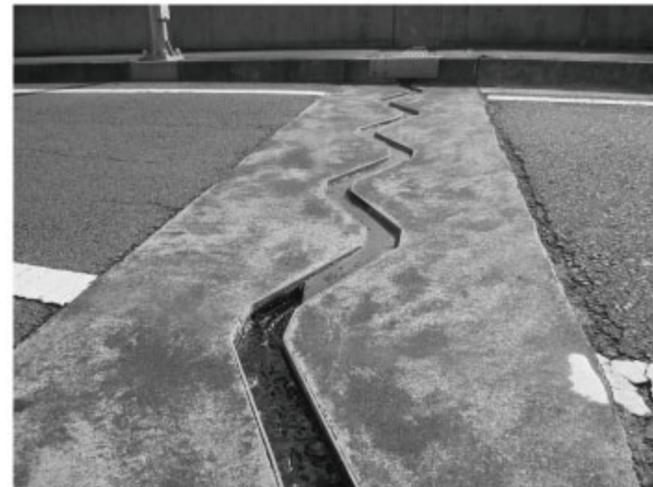
スカイシールF11は、ポリブタジエンを主成分とする二成分型弾性シール材であり、優れた接着性、復元性、耐水性、耐久性を示します。主剤と硬化剤の混合物は流動性に優れ、伸縮装置への充填作業が容易です。また硬化後は極めて柔軟性のあるゴム弾性体となり長期にわたって、シール性、防食性、耐震性を発揮します。主に、橋梁・道路のフィンガージョイントや簡易ジョイント、また、配管の伸縮吸収管の止水・緩衝の用途で採用されています。また、常温で硬化しセルフレベリング性が良好なので簡単に効率よく施工が行えます。
