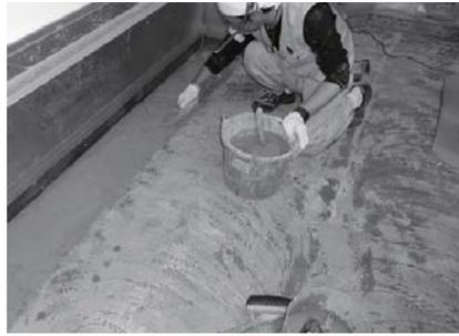
ろができます。速硬型で薄付けから厚付けまでこれ一つで可能ですので、一発充填にて鏝にて仕上げました。この現場では1時間後には、次の現地調整材を施工していただきました。
