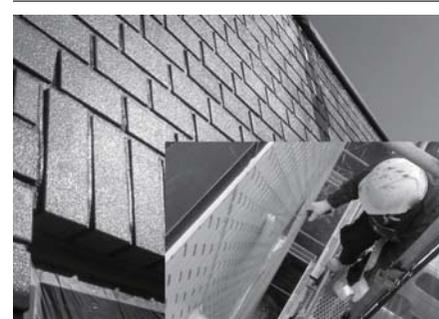
②「使用材料はすべて1液型」 前述の3種類の材料はすべて1液型の材料となっており、現場での計量や、煩雑な材料の混合作業が必要ありません。その為、現場には材料と作業用のローラー・刷毛さえあれば施工が可能で、電動攪拌機も必要ないため、騒音のない静かな施工が可能です。
