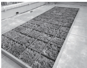
学校施設 屋上 (VUS500)
