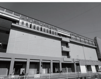
駅ビル工事現場外観
