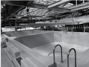
いつも受水槽等の飲料用水槽の内面防水工法として、全国の様々な現場にて採用頂いております。「ビッグサンGR-J工法」ですが、今回、某水産技術センターの魚類飼育水槽の改修工事で採用頂き、先日無事に工事も完了しましたので紹介させていただきます。
