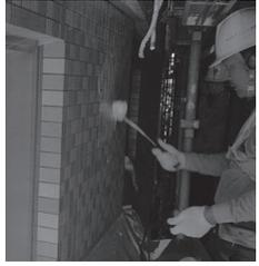
今回紹介させて頂く現場は、テナントビルの外壁タイル面から漏水が発生して、施工業者様から施工主様の提案で「スカイコートW」を薦めて頂き採用に至りました。現場はタイルの浮き等もあり、樹脂注入等、しっかりと下地処理をした上で施工を行いました。
