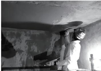
埼玉県某浄水場では、高度浄水処理施設の躯体保護の必要性を認識されており、平成31年度に生物活性炭吸着池防食塗装修繕工事として「ビッグサンUGA工法」を採用頂きました。一度にすべての水槽の稼働を止められず、数年単位の工事を分割することになり、令和2年度にも引き続き工事が行われ、弊社も現場施工に立ち会わせて頂きました。
